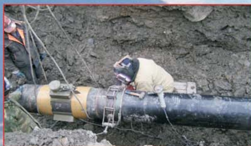
Врезка патрубка измерительного
